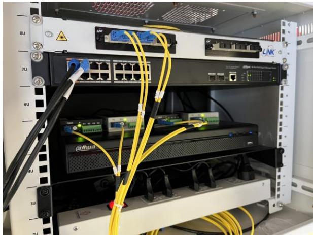
ระบบเครือข่ายหลัก ไฟเบอร์ออฟติกดำเนินการแล้วเสร็จ จากตู้วัดค่าโหลดแรงสูงไปยังอาคาร 2
