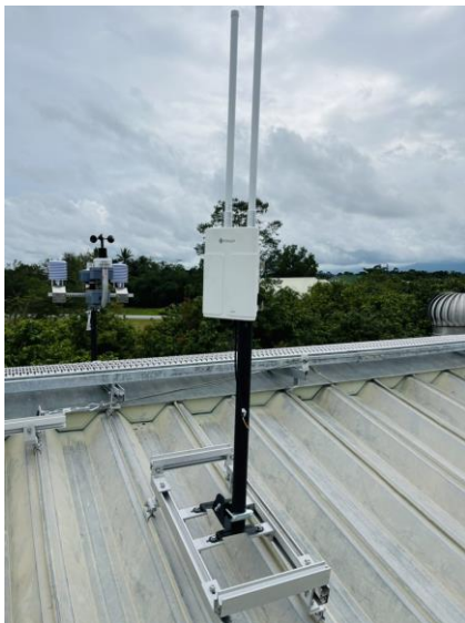
ระบบส่งสัญญาณลอราและเซ็นต์เซอร์ดำเนินการติดตั้งแล้ว
