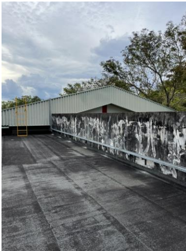
บันไดสำหรับขึ้นอาคารดำเนินการเสร็จเรียบร้อย และมีทุกอาคาร
